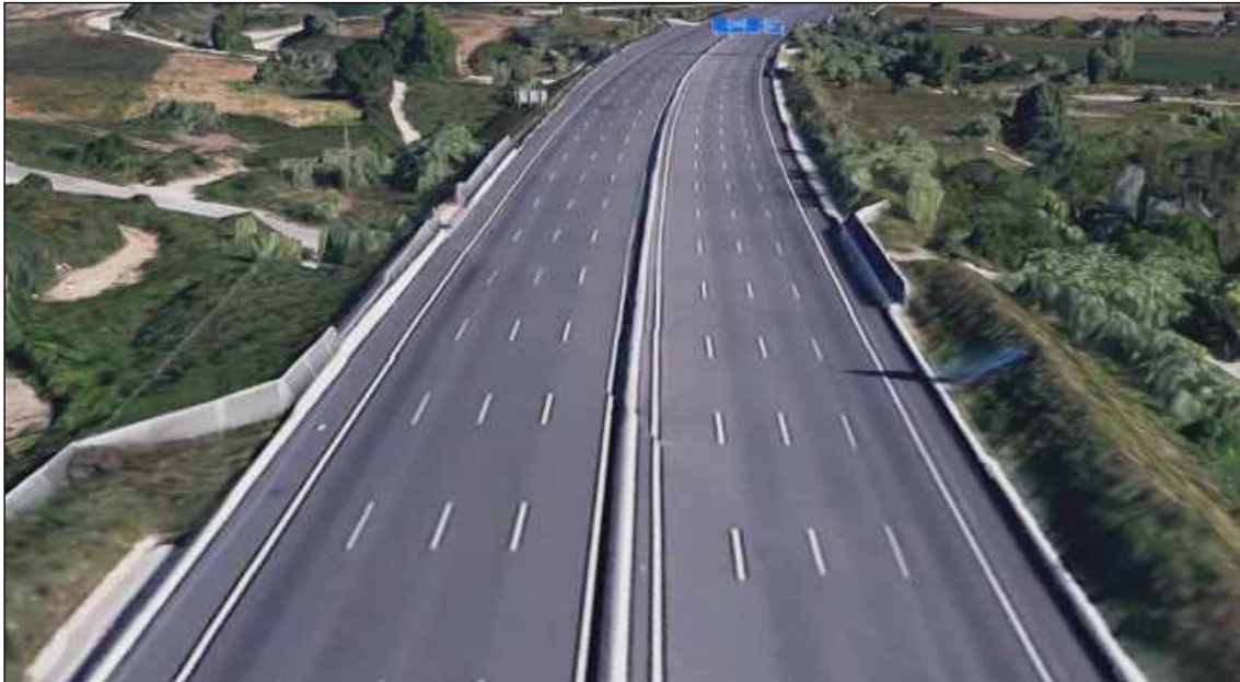
Imatge 4 – Vista de la infraestructura objecte d'estudi
